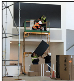
Instalación de monitores
