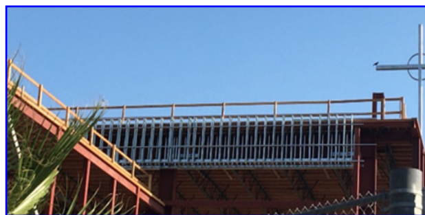
Encuadre para el parapeto del techo de la iglesia
