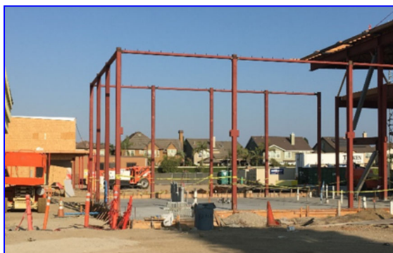
La Sacristía de la Iglesia está ahora enmarcada
